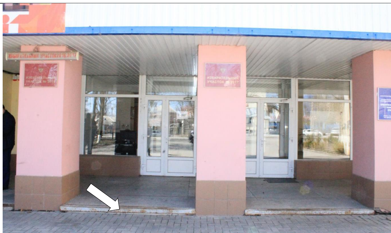
Фото № 4. На главном входе имеется перепад высоты. Дверные проемы, дверные ручки и прозрачные проемы дверей не имеют контрастной маркировки.
