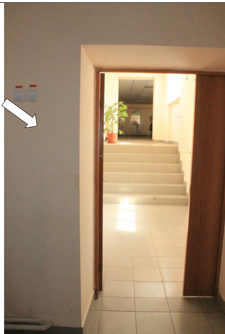
Фото № 17. Узкий дверной проем.
