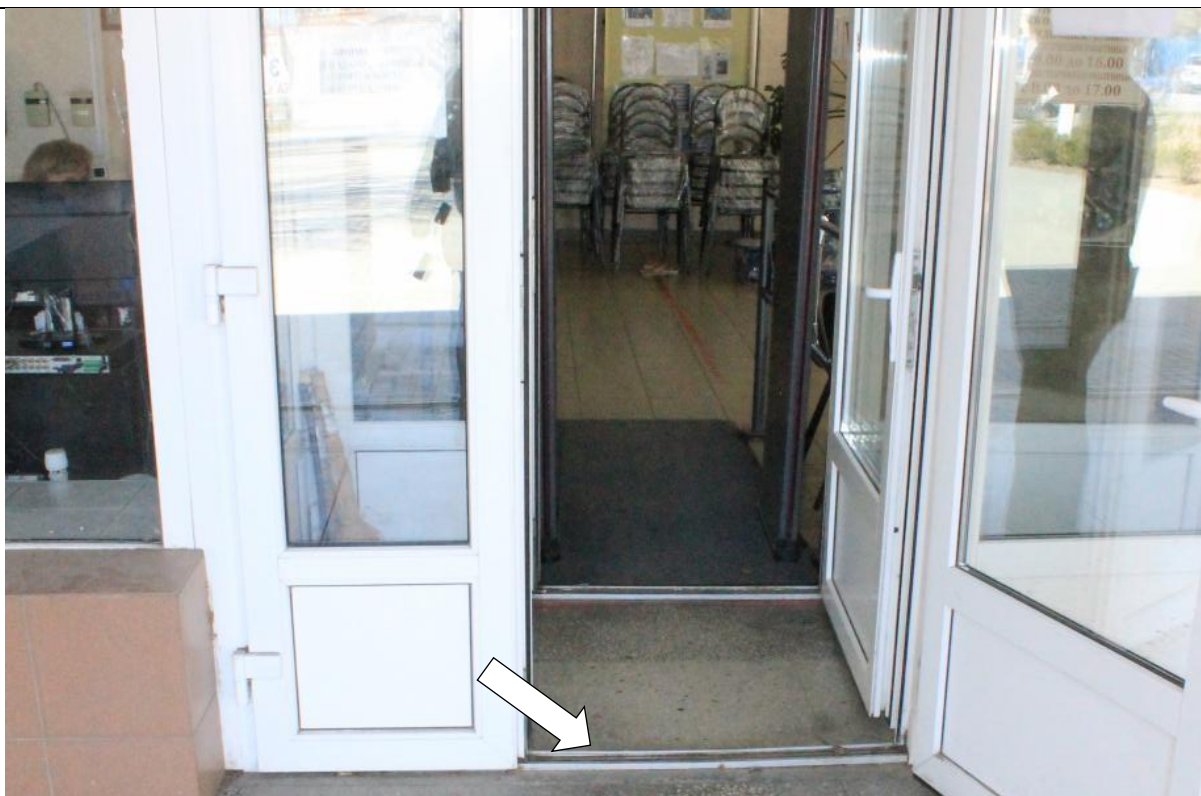
Фото № 5. Узкий дверной проем. В дверном проеме порог.
